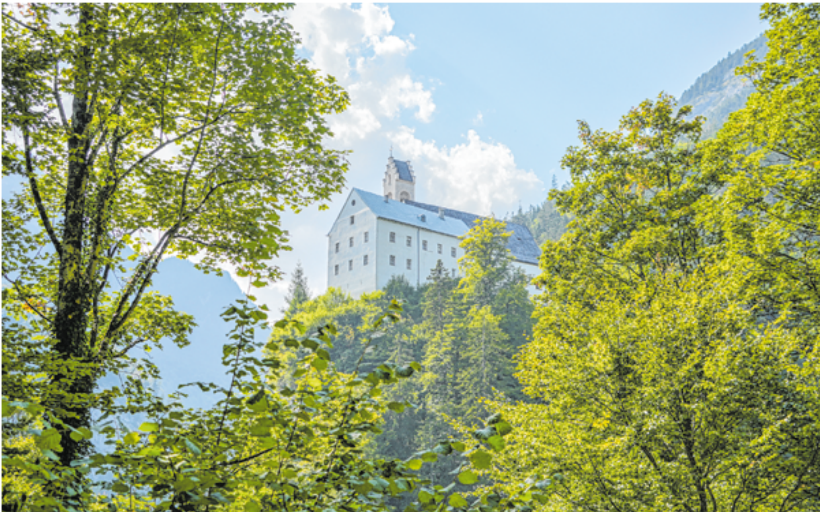
Weithin sichtbar thront das Felsenkloster über dem Inntal auf dem Georgenberg: Ein Ort der Stille und Einkehr für all jene, die danach suchen.
