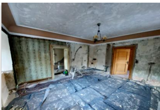
Hier entstand mittlerweile die neue Küche.
