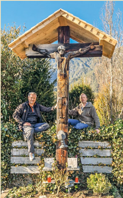
Jens und Harry erneuerten das Dach des Kreuzes beim Priestergrab.
