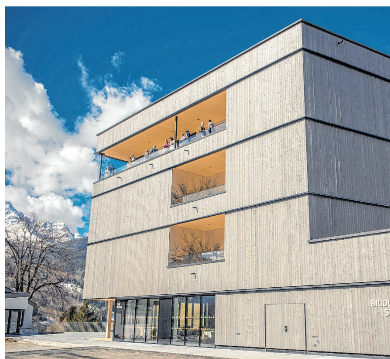
Das Bildungshaus St. Michael in Matrei am Brenner ist ein Vorzeigeprojekt für Nachhaltigkeit.
