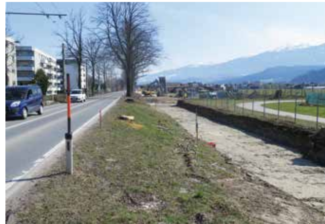
Fundament neue Landesstraße/Kranebitter Allee 2015 Foto: P.P. Steinringer
