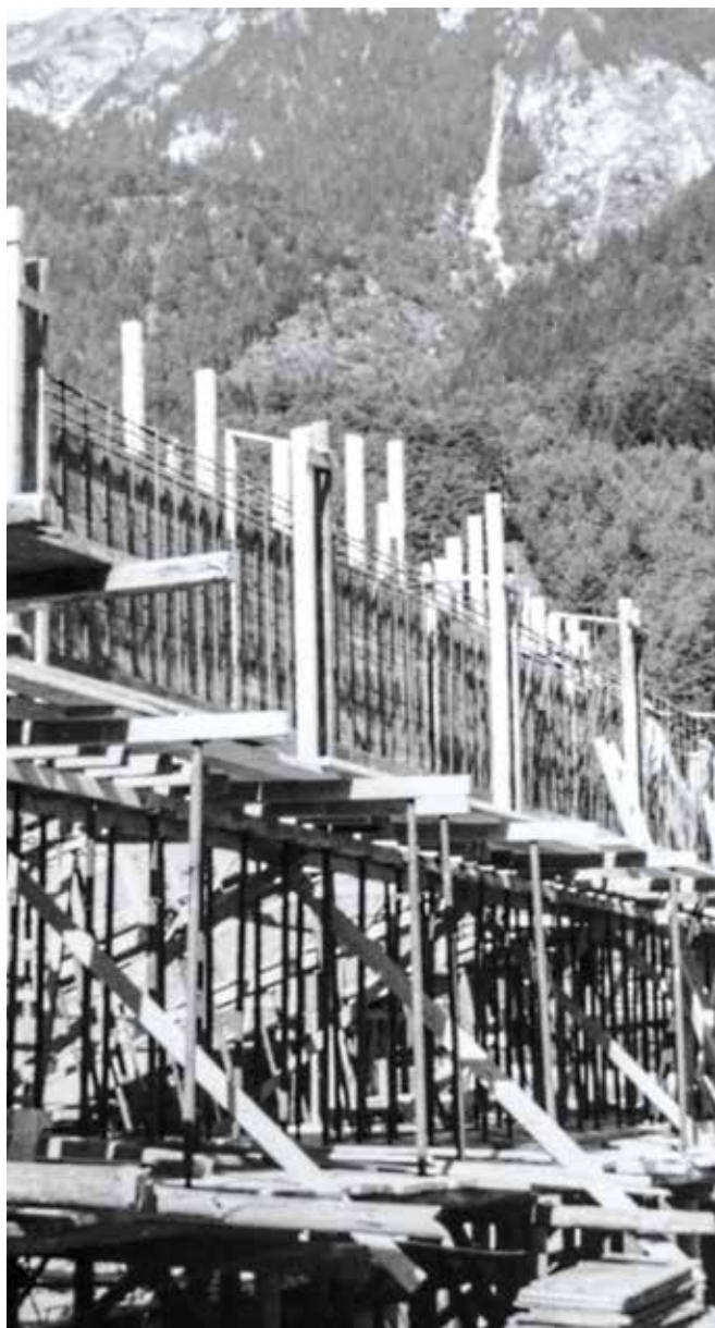
Schalung des Mittelträgers | Foto: Benesch
