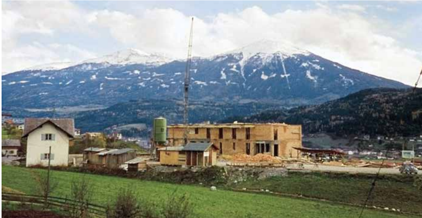
Bau des Pfarrhauses 1961 | Foto: Fam. Csollich
